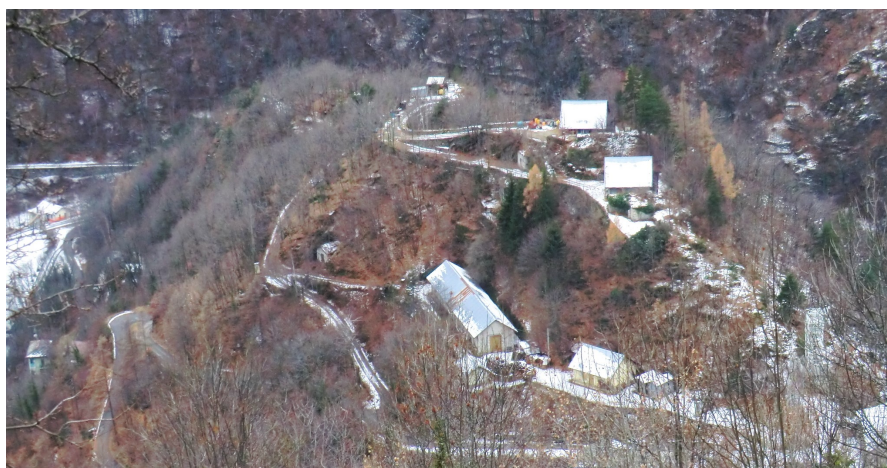
Resti delle strutture facenti parte della batteria "Monte Castello" di Perrero
