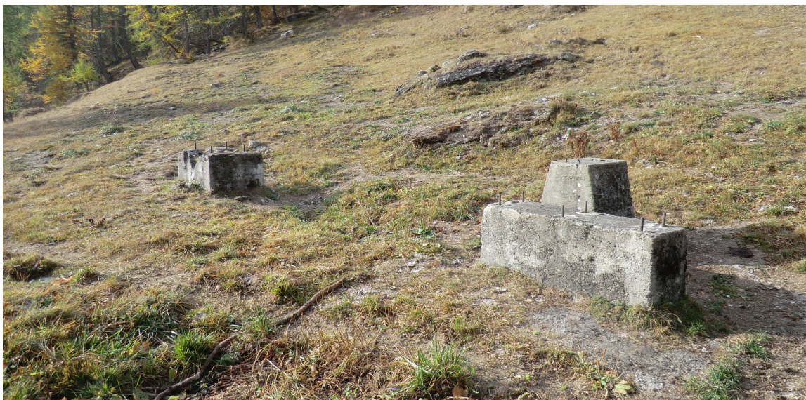
Basamenti per una teleferica e o per qualche altro impianto nei pressi dell'Opera 18a
