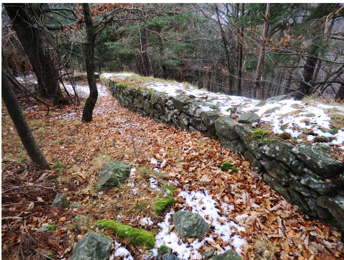
Alcuni tratti di muratura e trincea nella zona di Podurant (Perrero) come apparivano nel 2016
